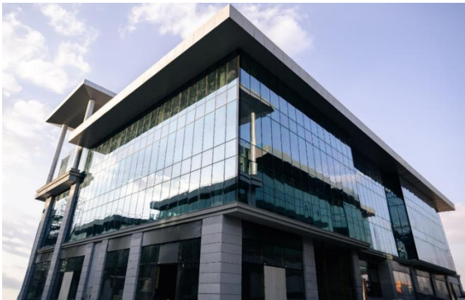
مبني A5- مشروع جولدن جيت
